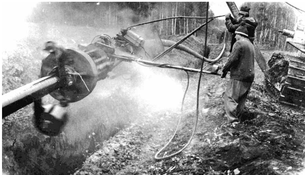
С первых дней работы Томское УАВР выполняло сложнейшие работы по ремонту трассы
