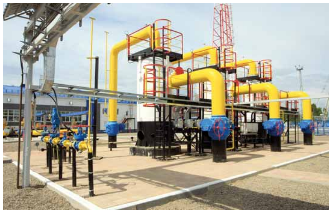
КС «Парабель». Станция после реконструкции значительно повысит надёжность работы газотранспортной системы ООО «Газпром трансгаз Томск»
