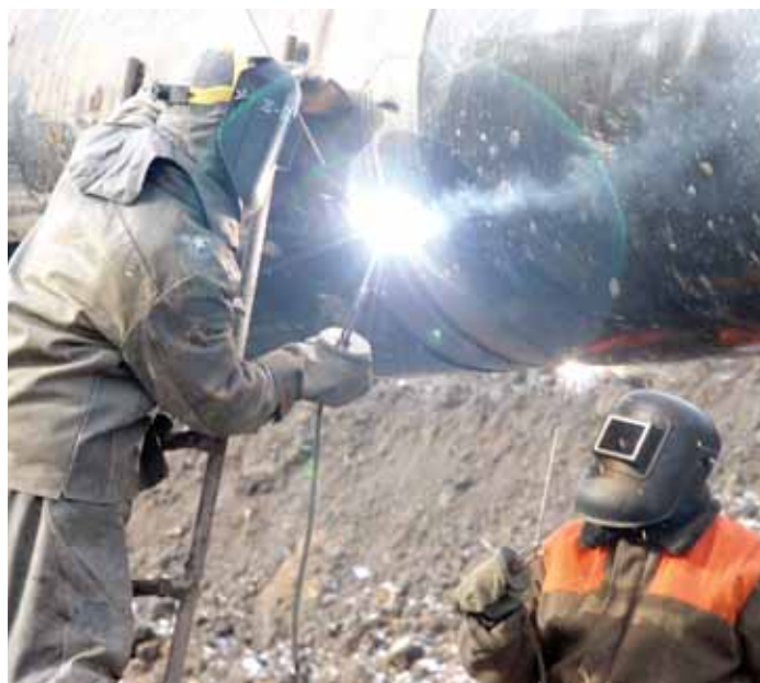
Сварщики ТУАВР понимают степень ответственности своей работы
